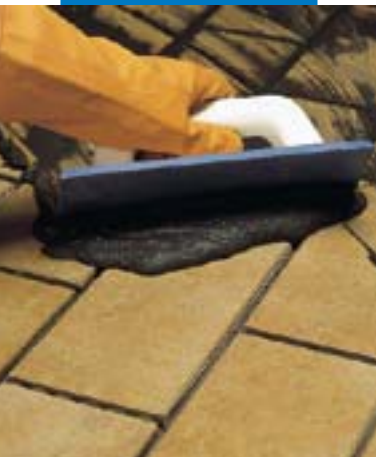
Rejuntado de pavimentos exteriores de Klinker con Keracolor GG mezclado con Fugolastic
