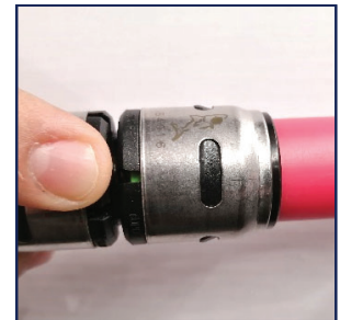
Inserta manualmente el tubo en la conexión hasta que el indicador verde sea visible
