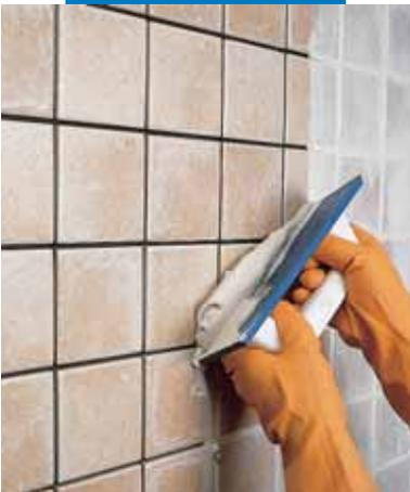
Rejuntado de recubrimiento de monococción con llana
