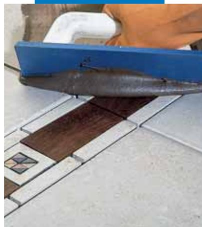
Rejuntado de pavimento cerámico con inserciones de madera, con llana
