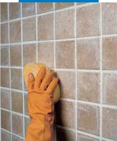
Acabado de recubrimiento de monococción con esponja
