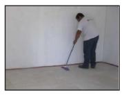
2- Aplique el adhesivo acrílico (Lanco SUPREME o similar) sobre la superficie de la lámina Plycem, usando una llana o plancha lisa, dejando una capa delgada.
