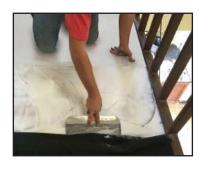
3- Inmediatamente coloque el geotextil y extiéndalo sin dejar traslapos ni pliegues sobre la superficie y con la misma plancha lisa presione hacia abajo.
