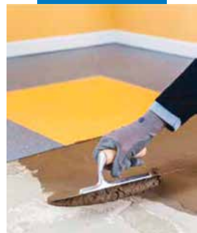
Regularizando la superficie a un borde de pluma
