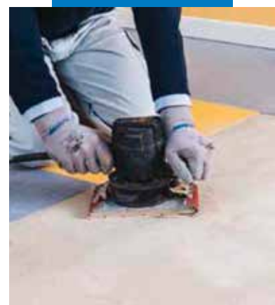
Lijando la superficie después de 2 horas
