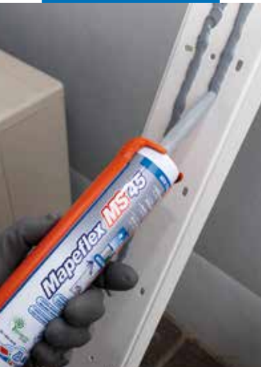
Encolado de perfiles de plástico en exteriores
