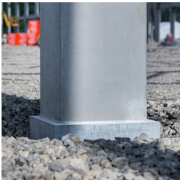
Grouteo de placas base
