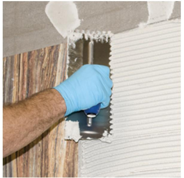
Aplique el mortero en una sola dirección con el lado dentado de la llana
