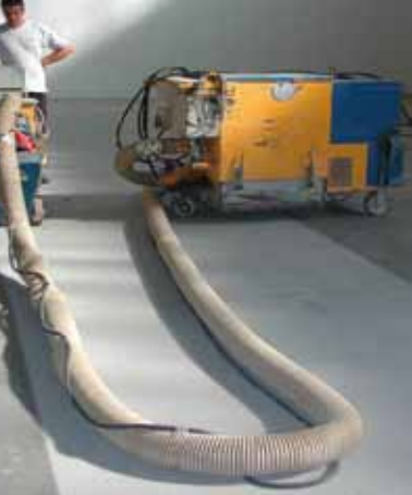
Preparación del soporte mediante granallado
