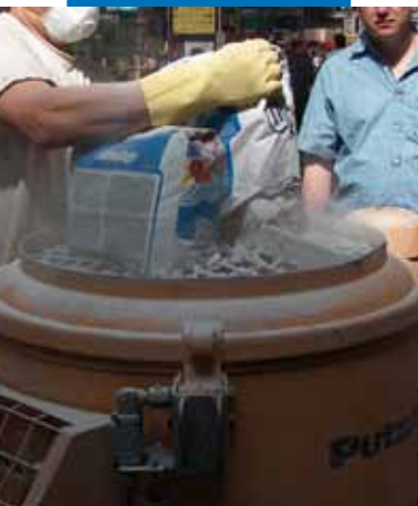
Preparación del producto en la máquina antes del bombeo
